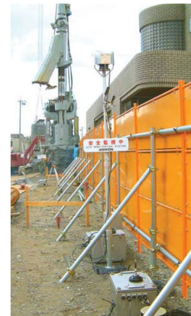
カメラ監視装置と画像データ処理により、設定した安全領域内で作業が行われるよう施工機械の挙動を自動制御。
