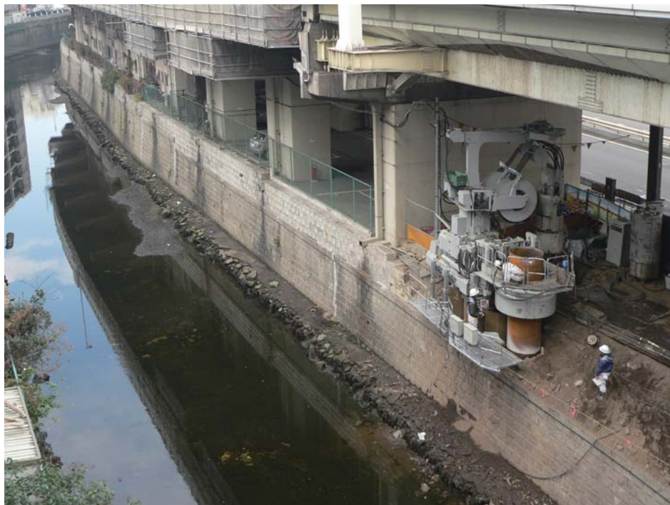
ジャイロプレス工法による都心での護岸整備工事
